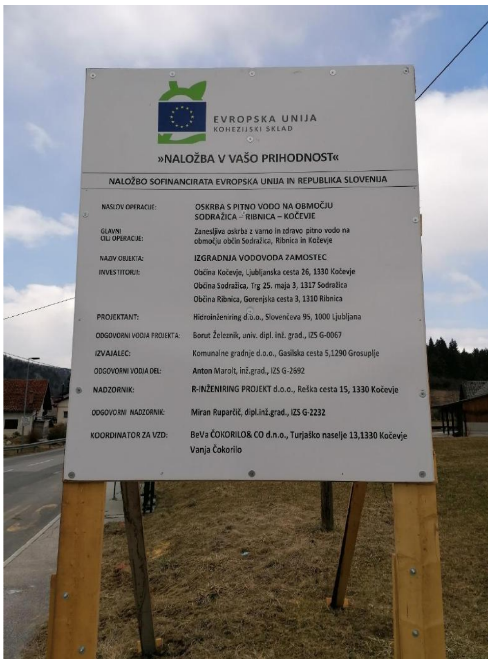
Obvestilna tabla o izvajanju projekta Izgradnje vodovoda v Zamostcu.
