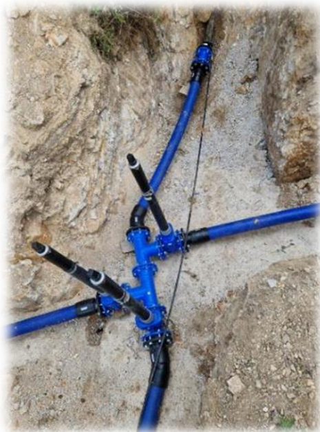
Novo "križišče" cevi v Janežih
