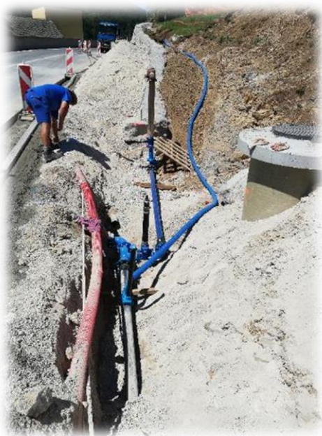
Prestavitev cevovoda v Vinicah
