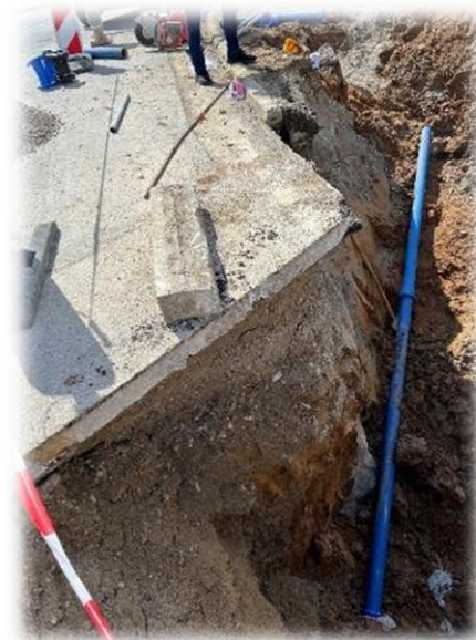
Izkop za prevezavo na obstoječi vodovod (globina 2,80m)
