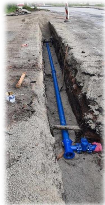
Izkop kanala, polaganje cevi in izdelava odcepa z zasunom
