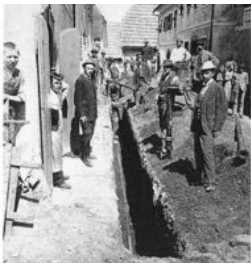
Izkop jarka za vodovodno omrežje v mestu Kočevje, 1896. Pokrajinski muzej Kočevje.
