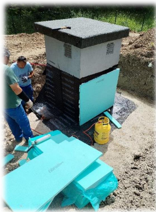
Izoliranje zračnikov
