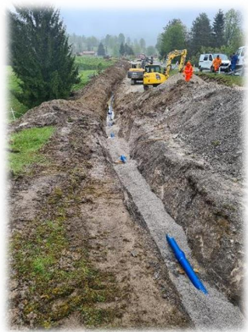
Prestavitev cevovoda Štalcerji
