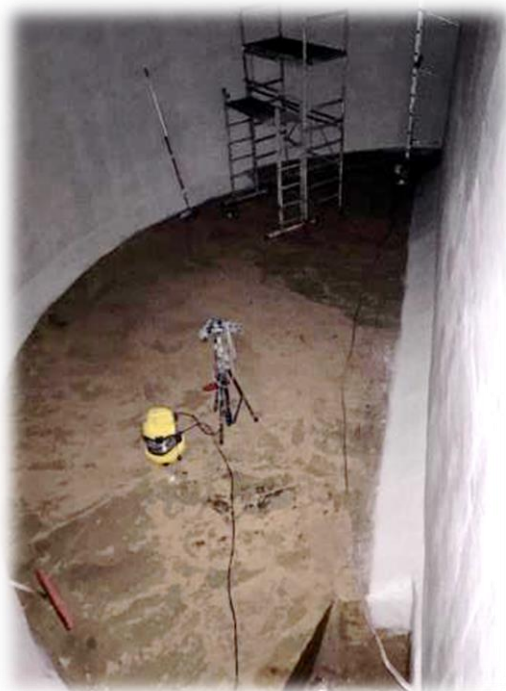
Obnova notranjosti celice
