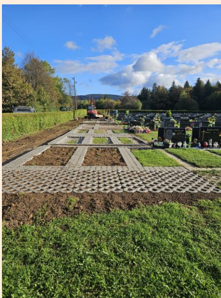
Slika 30: Izgradnja novih grobnih polj na pokopališču Videm
