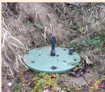
Slika 13: Cisterna za izcedne vode iz deponije nenevarnih odpadkov Mala gora
