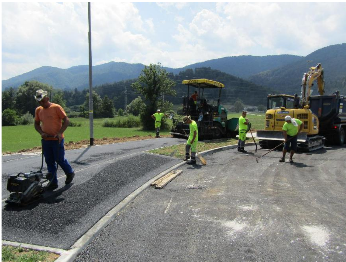
Gradnja krožišča na Vinicah.
