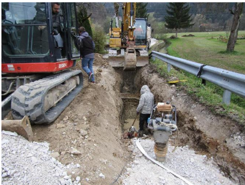
Pričetek gradnje kanalizacije v Zamostcu jesen 2024.
