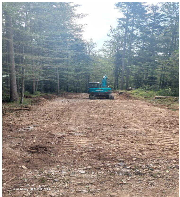
Gradnja dostopne poti do vetrnih elektrarn na Gori.
