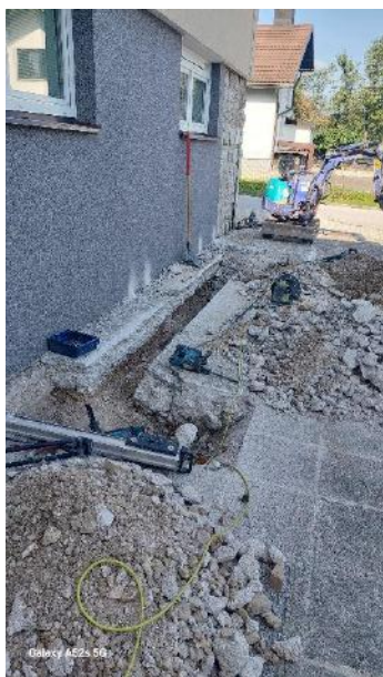
Sanacija radona v enoti lekarna.
