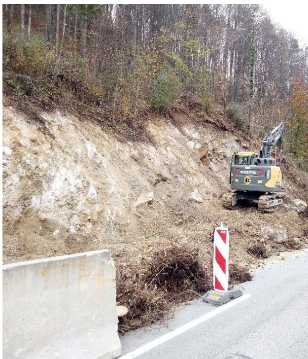
Sanacija brežin ob državni cesti v Sodražici jeseni 2024.
