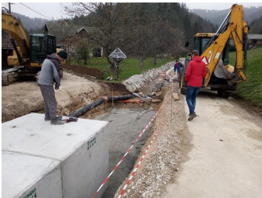
Ureditev struge Perilščice in gradnja novega mostu v Žimaricah 2024.
