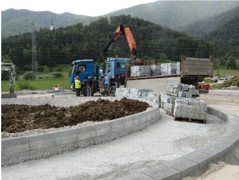
Gradnja krožišča na Vinicah poleti 2024.
