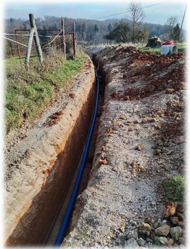
Slika 8. Obnova vodovoda Mozelj
