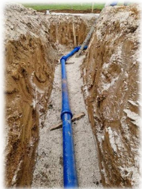
Slika 17: Obnova v Sajevcu
