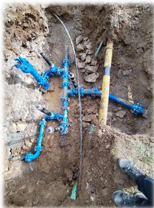
Slika 6: Prevezave cevi v Mestnem logu
