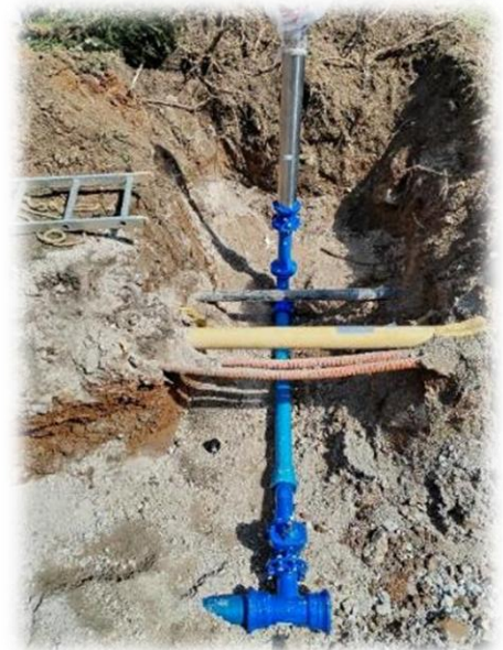
Slika 3: Zahteven izkop zaradi obstoječih instalacij
