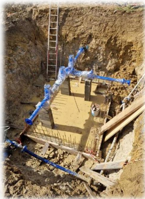
Slika 16: Obnova v Sajevcu
