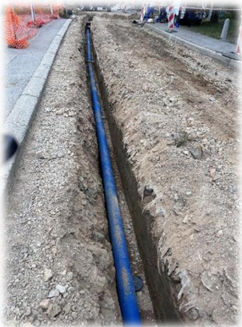
Slika 4: Prestavitev cevovoda Pri Unionu
