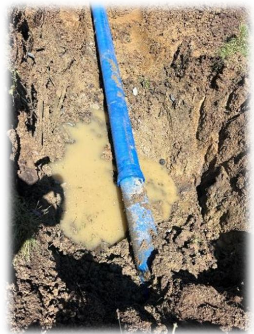
Slika 5: Zahteven izkop in montaža cevi DN300
