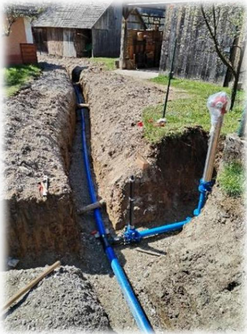
Slika 25: Obnovljen cevovod v Sodevcih
