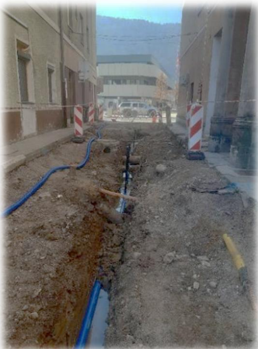
Slika 14:: Obnova komunalne infrastrukture TZO
