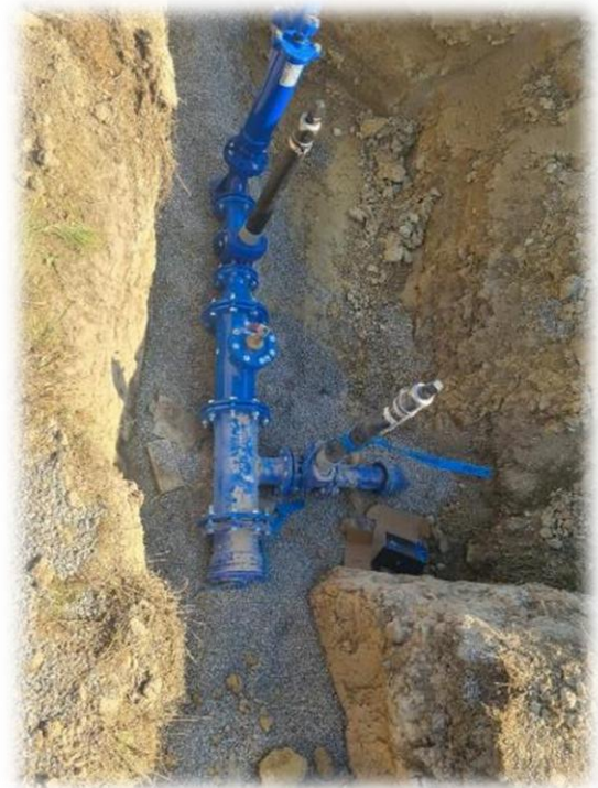
Slika13: Prevezava za odjemno mesto Yaskawe
