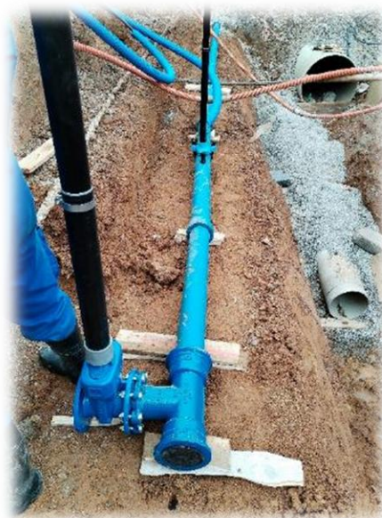
Slika 2: Izkopen kanal, polaganje cevi in izdelava odcepa z zasunom
