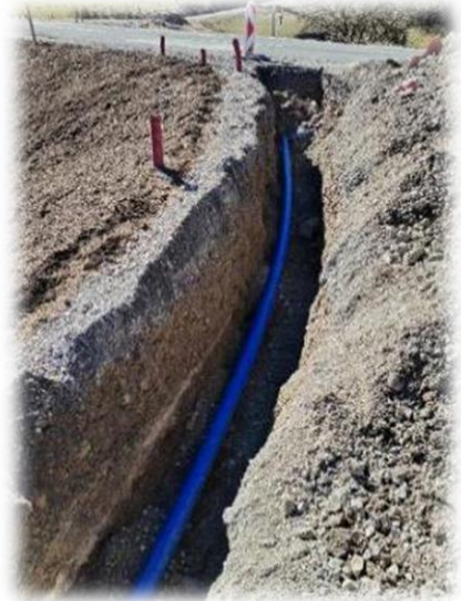
Slika 15: Izkop in položena cev v Moravi
