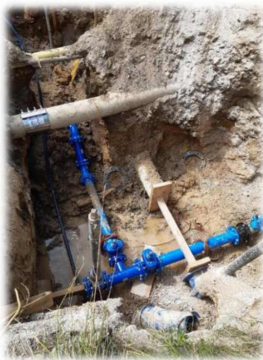
Slika 1: Odcep za novi cevovod v Nemški vasi
