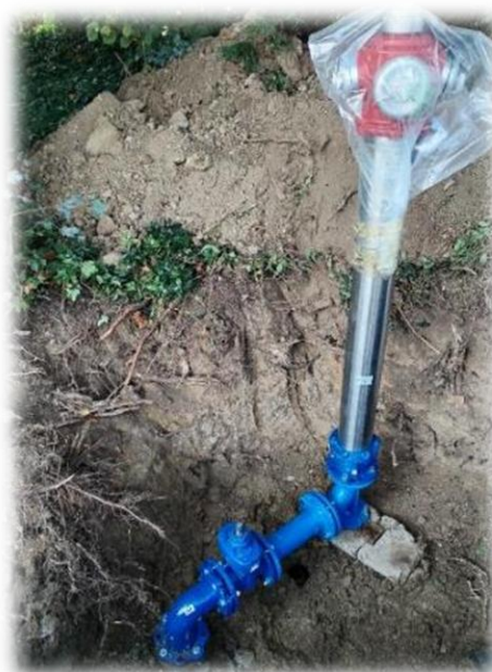
Slika 18. Zamenjani hidrant v Ribnici
