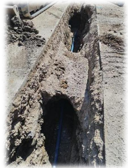
Slika 24. Trasa novega cevovoda in ovire, ki smo jih premagovali
