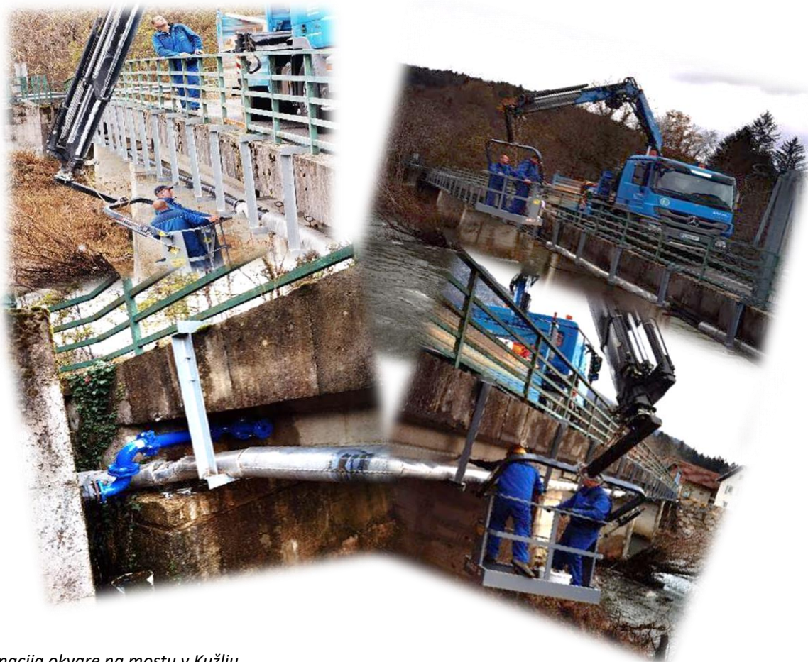
Sanacija okvare na mostu v Kužlju
