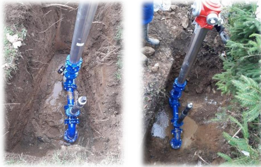
Zamenjan hidrant in zasun
