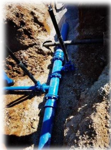
Nov odcep za blok UHM
