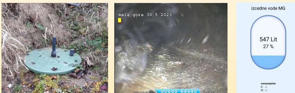
Slika 14: Snemanje in čiščenje vrtine za izcedne vode iz deponije nenevarnih odpadkov Mala gora
