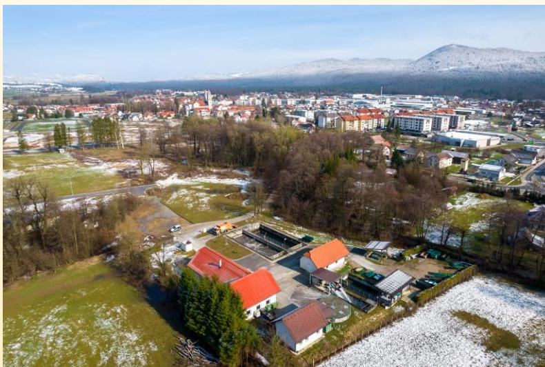
Slika 16: Čistilna naprava Ribnica
