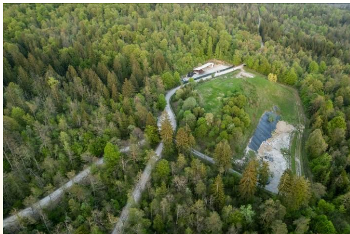
Slika 15: Deponija za inertne odpadke
