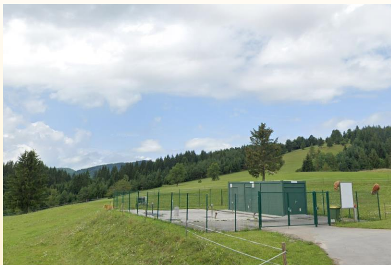
Slika 23: Čistilna naprava Mali Log
