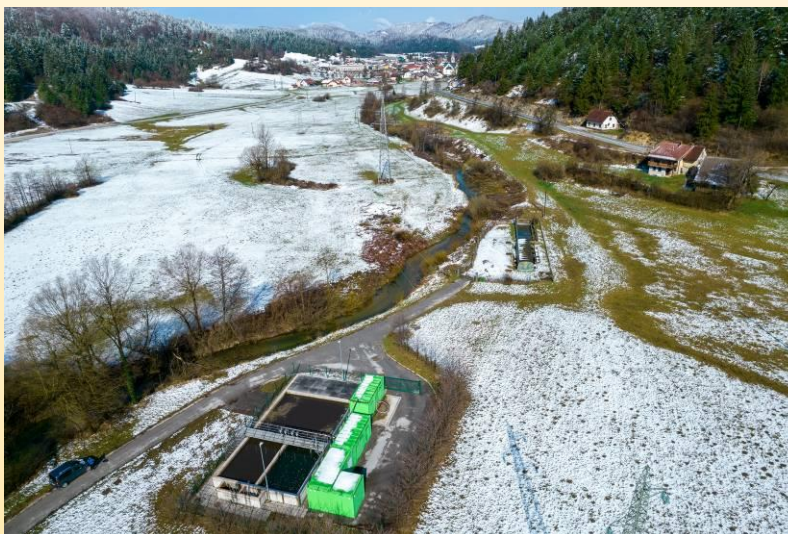
Slika 20: Čistilna naprava Sodražica
