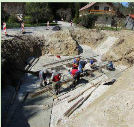
Gradnja novega mostu v Podklancu
