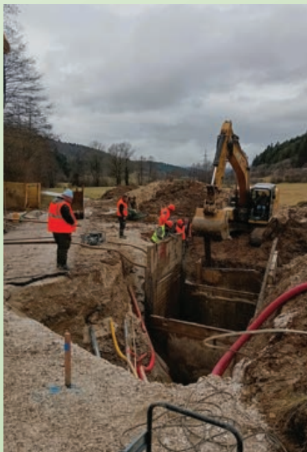
Izgradnja kanalizacije v Zamostcu prehaja v zaključno fazo.
